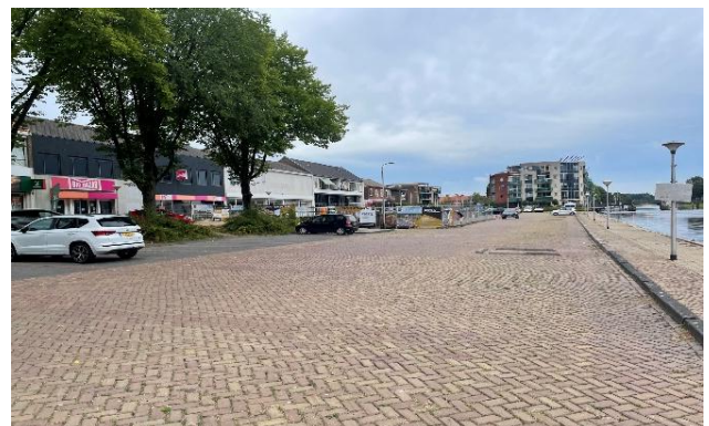
Foto van Zuiderkade met de bouwhekken geplaatst.
